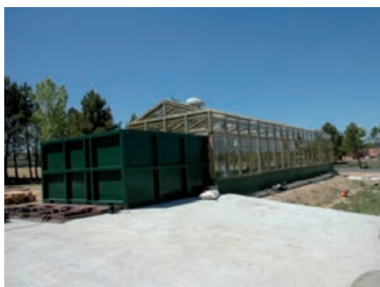
IMAGEN 1. SECADERO HÍBRIDO SOLAR DE BIOMASA (CEDER).
